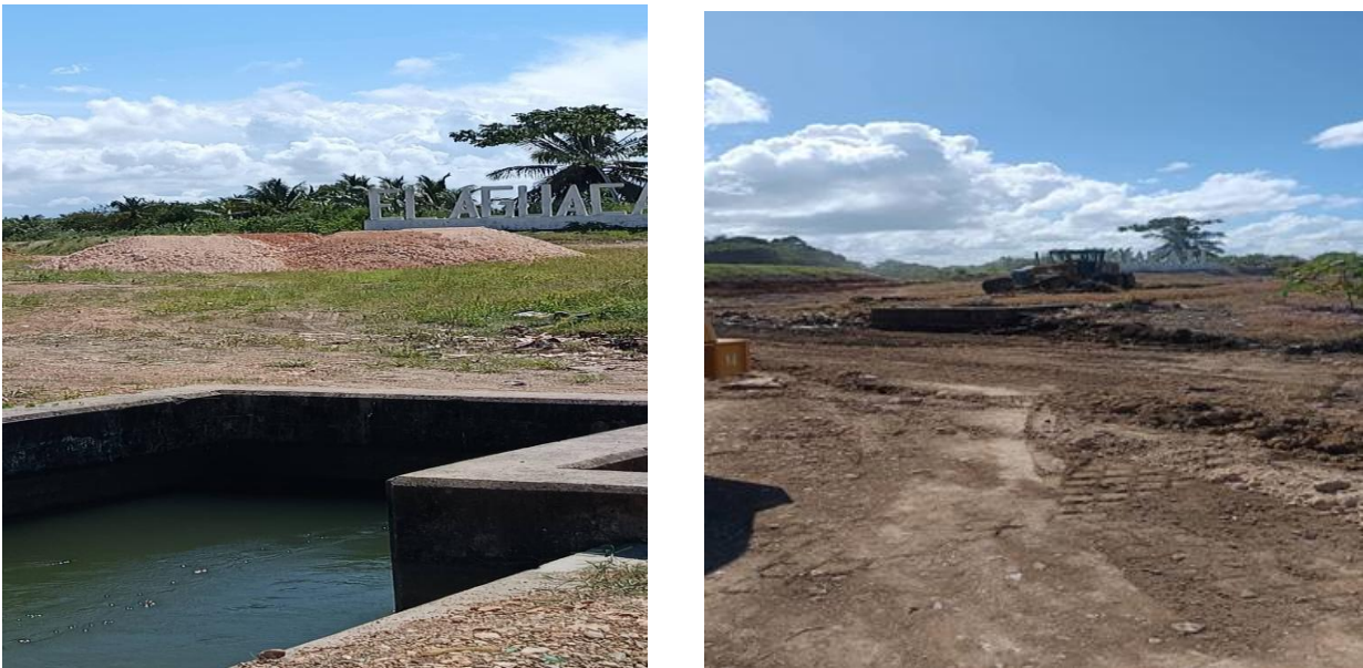
12. Limpieza y relleno donde se va a construir el parador fotográfico
