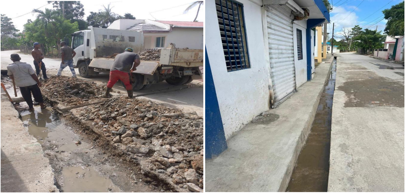
11. Canaleta de la escuela primaria al canal mayor
