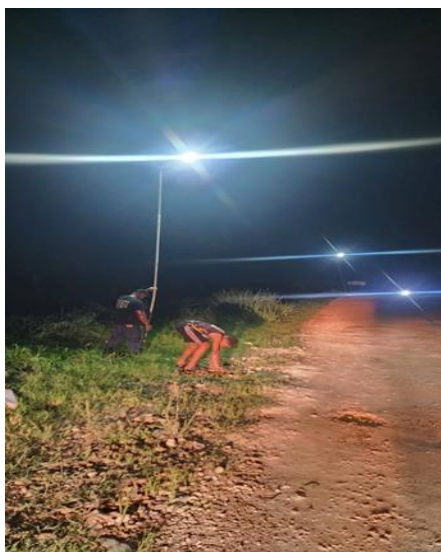
18. Alumbrada de la entrada de la mina.
