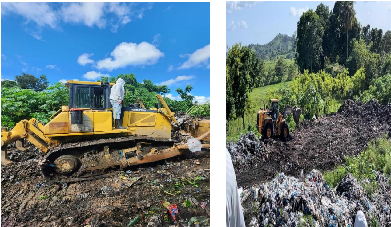
27. Mantenimiento de limpieza del Vertedero con equipo pesado.
